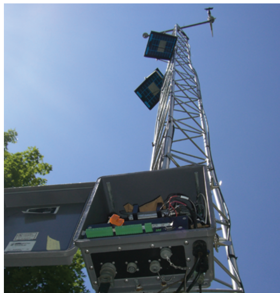
Tour d'évaluation météorologique comprenant un enregistreur de données YSI et des capteurs météorologiques.
