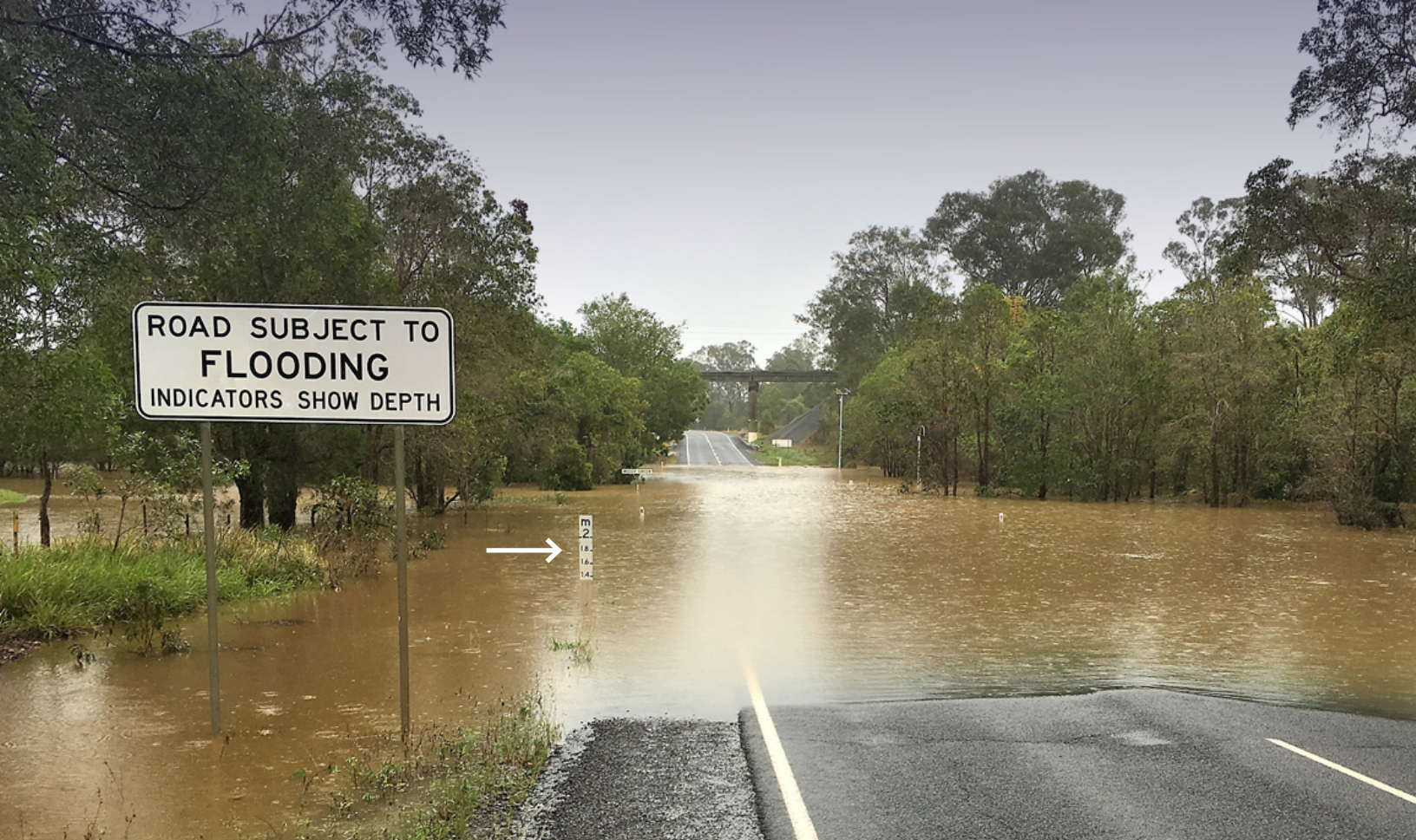
Fermeture de la route à cause des inondations. Remarquez la jauge d'état-major (flèche), un outil utile pour les conducteurs.
